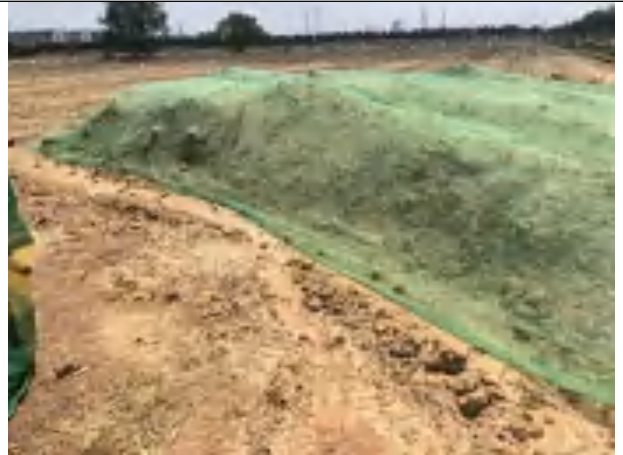
施工期防尘网苫盖措施
