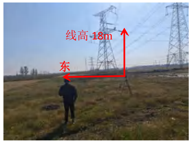
220kV 衡檀线单回架空 7 号~8 号塔间，向东衰减
