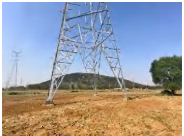
42号塔基平整复耕现状
