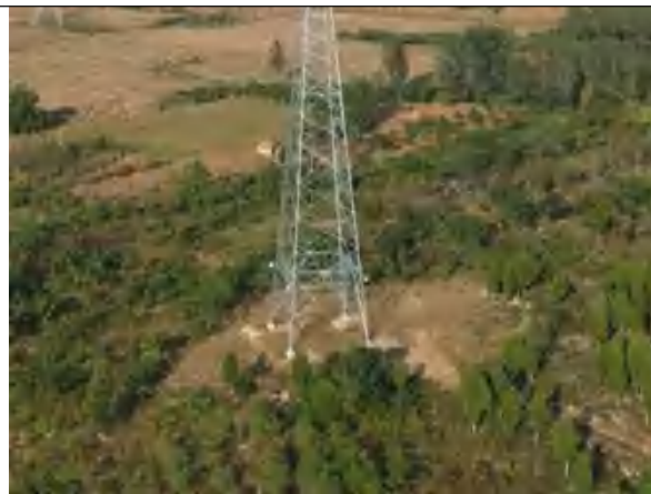
36号塔基植被恢复现状（一档跨越红线塔基）
