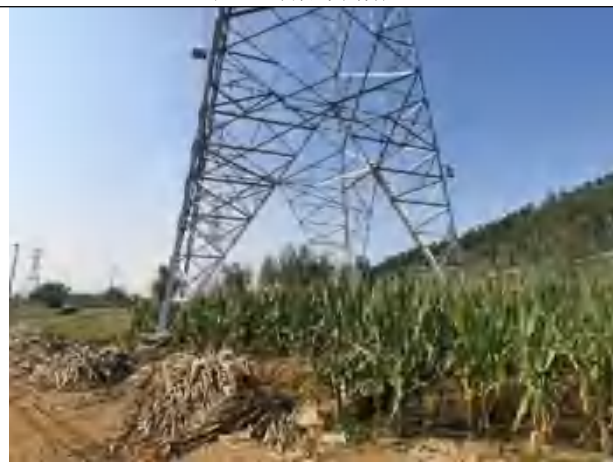
44号塔基复耕现状
