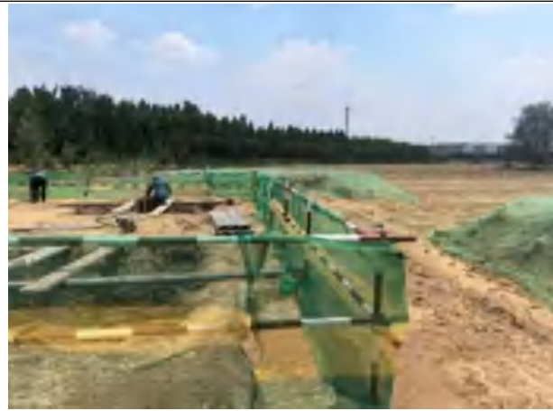
施工期限界措施
