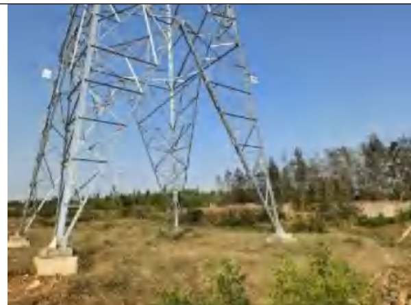
35号塔基植被恢复现状（一档跨越红线塔基）
