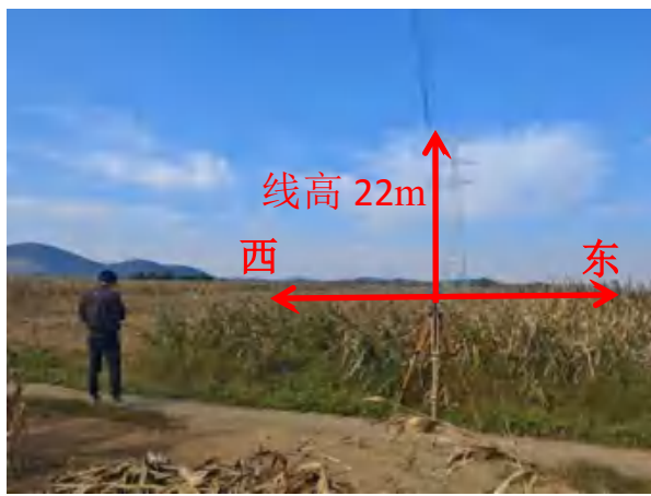
220kV 衡檀线双回架空（单侧挂线）24 号~25 号塔间，向东西衰减
